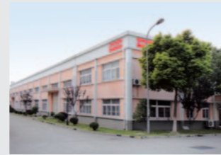
Franke Warehouse Shanghai/PRC
