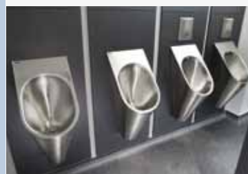
AQRE432 Armătură de clătire pisoar cu comandă optoelectronică, cu transformator integrat
