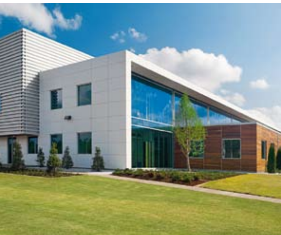
Neuer Standort für Franke Coffee Systems North America in Smyrna, Tennessee
